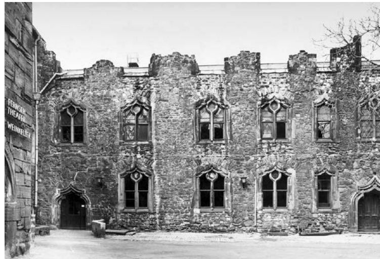
Innenhof der Moritzburg mit Blick auf den Nordflügel, 1957 (rechts) und 2019 (links)
