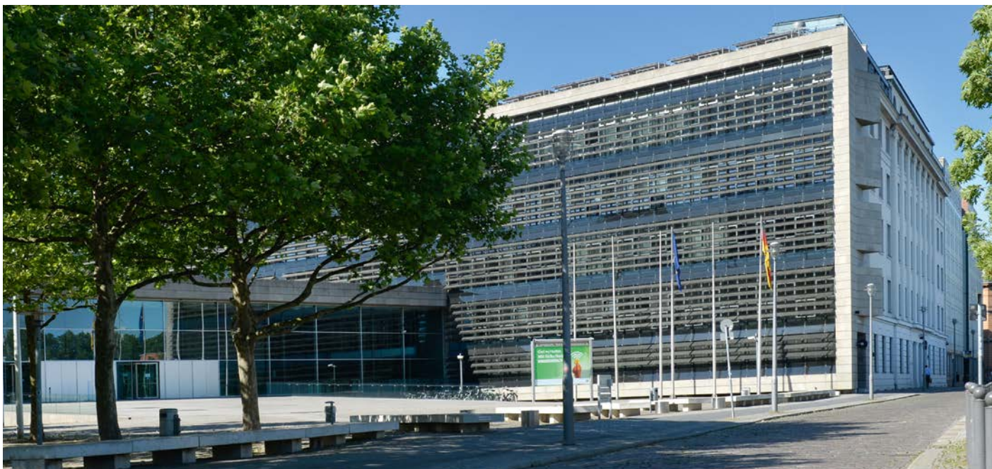
Lamellen vor den Fenstern reagieren automatisch auf Witterung und helfen, Temperatur und Licht im Gebäude zu regulieren.
