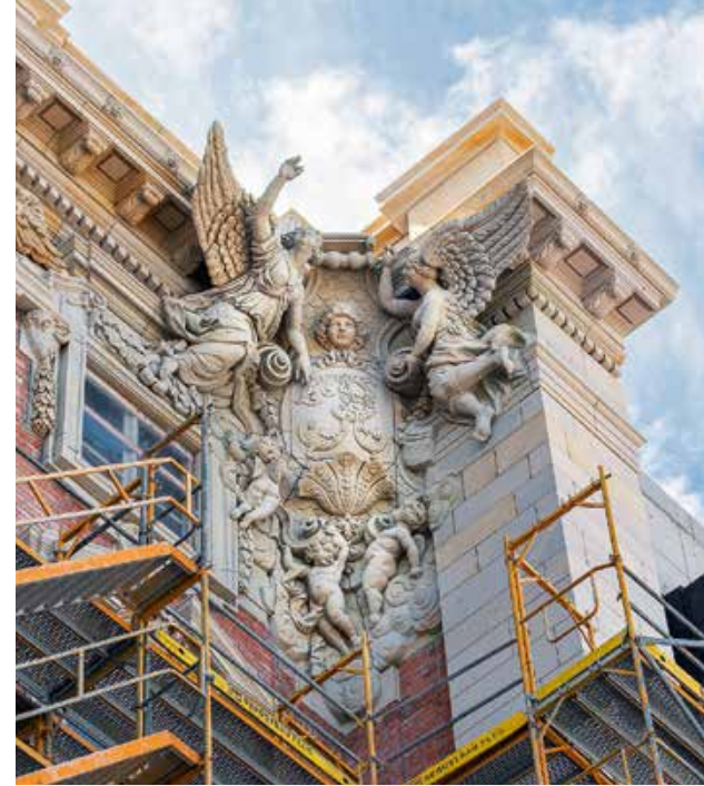
^ Rekonstruiertes Relief an der Nordfassade
